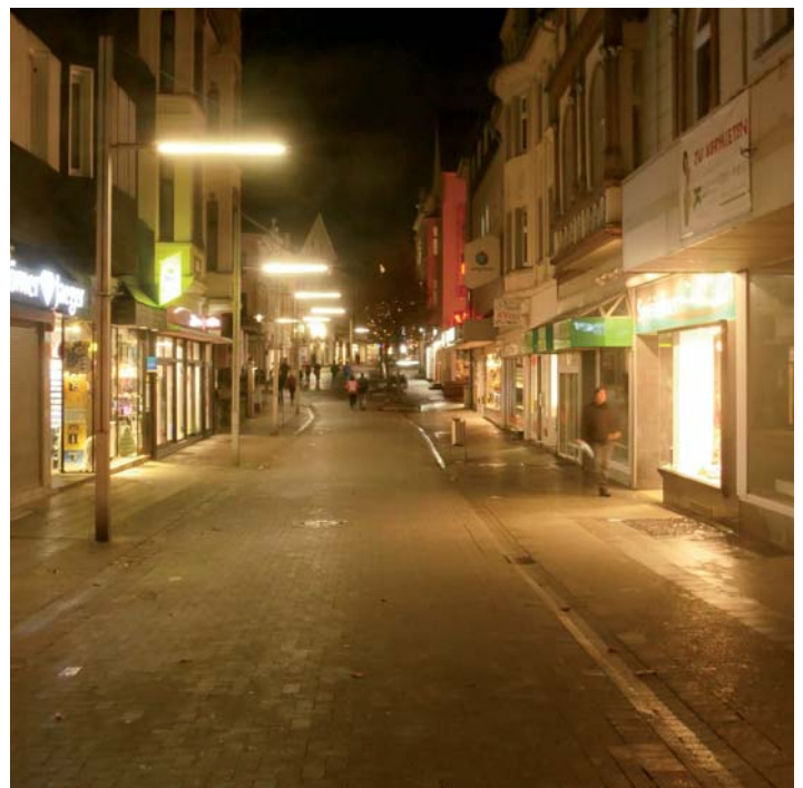
Foto Bestand Beleuchtung Fußgängerzone
