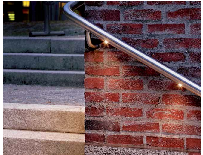
Referenzbild Treppenbeleuchtung über Handlaufleuchten
