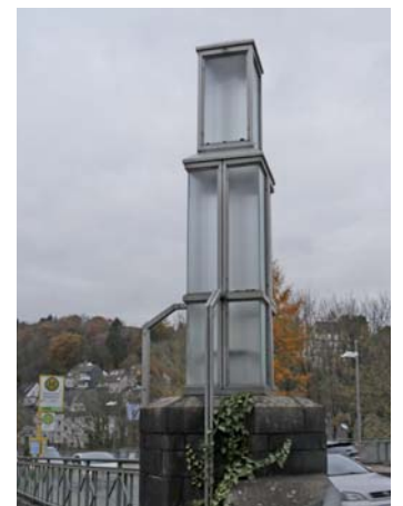
West: Reaktivierung Brückenbeleuchtung
