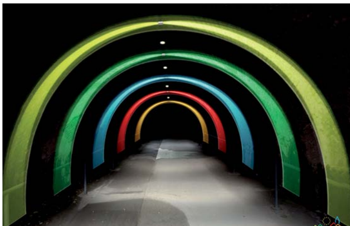
Gestaltung und Beleuchtung Fußgängertunnel
